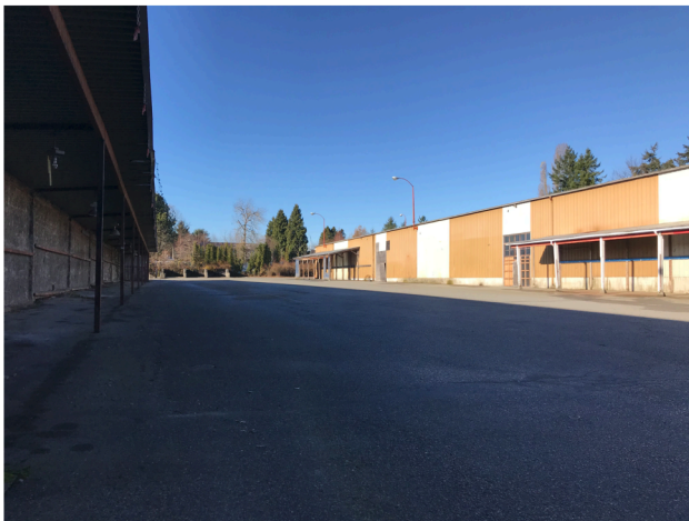
Bldg B IMG_5698.JPG
