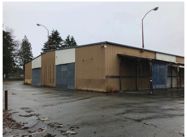
Bldg B IMG_5778.JPG
