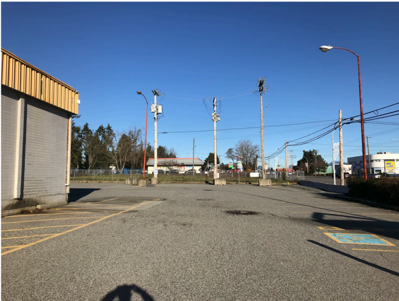
Hydro poles IMG_5720.JPG
