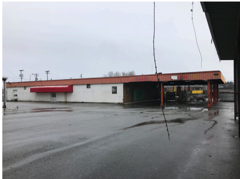
Bldg A IMG_5786.JPG
