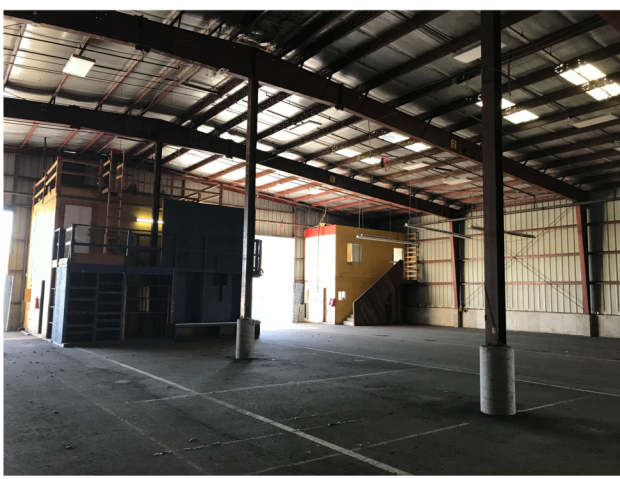
Bldg B IMG_5680.JPG
