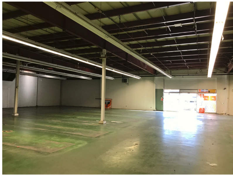
Bldg A IMG_5706.JPG
