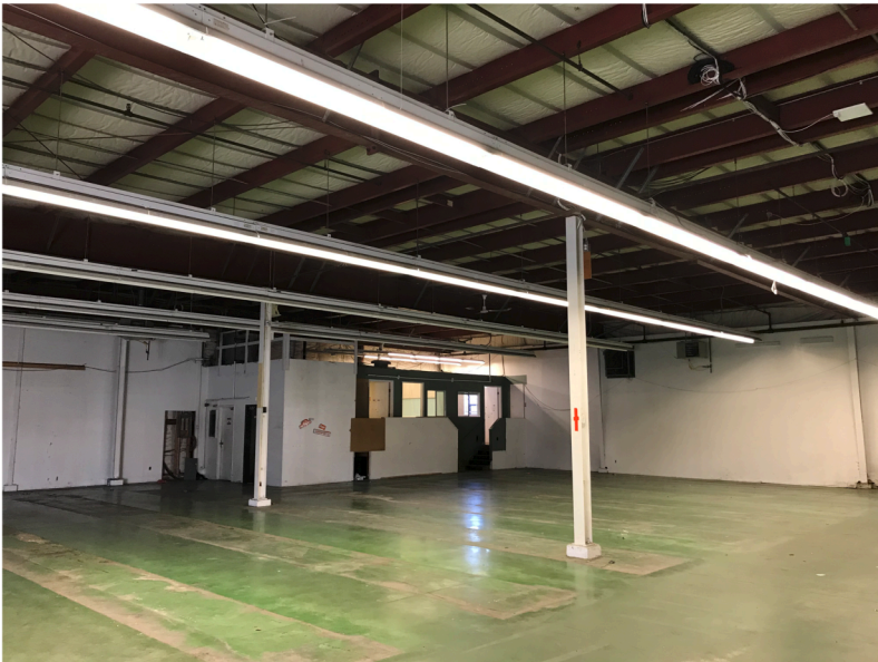
Bldg A IMG_5717.JPG
