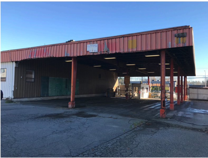
Bldg A IMG_5700.JPG
