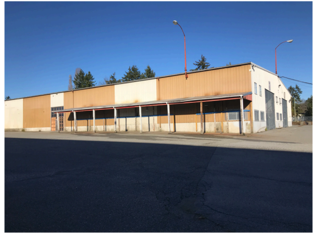
Bldg B IMG_5697.JPG
