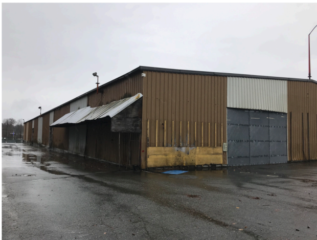
Bldg B IMG_5771.JPG
