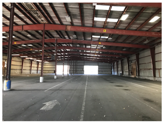
Bldg B IMG_5683.JPG
