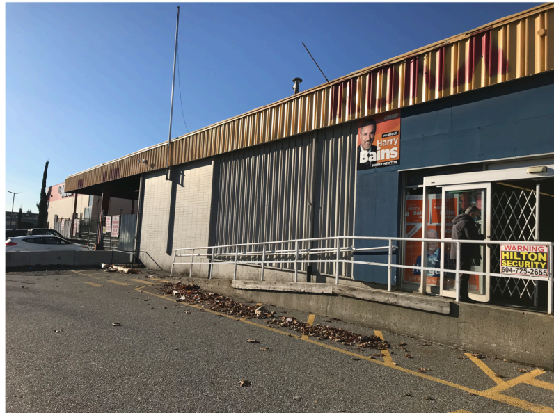
Bldg A IMG_5721.JPG
