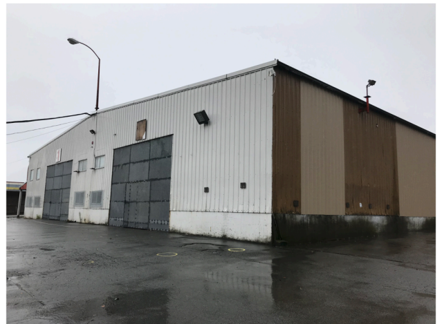
Bldg B IMG_5760.JPG
