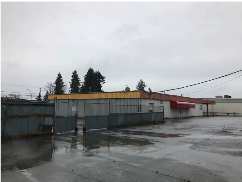
Bldg A IMG_5765.JPG
